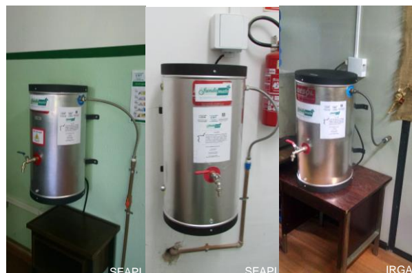
Três equipamentos para aquecimento da água para chimarrão (“quentinhas”) já se encontram instalados e em funcionamento. Fotos: SEAPI
